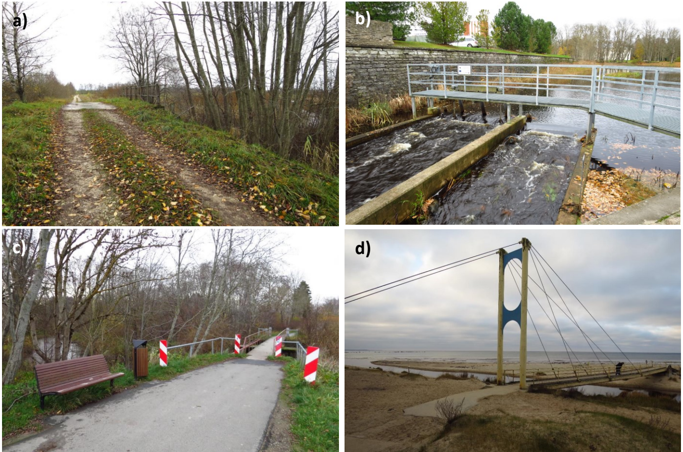
Joonis 9.19. Saunasilla tee sild (a); metallist platvorm Saku mõisa tiigi väljavoolu kohal (b); Kotka tee jalakäijate sild (c); jalakäijate sild jõe suudmes (d).
