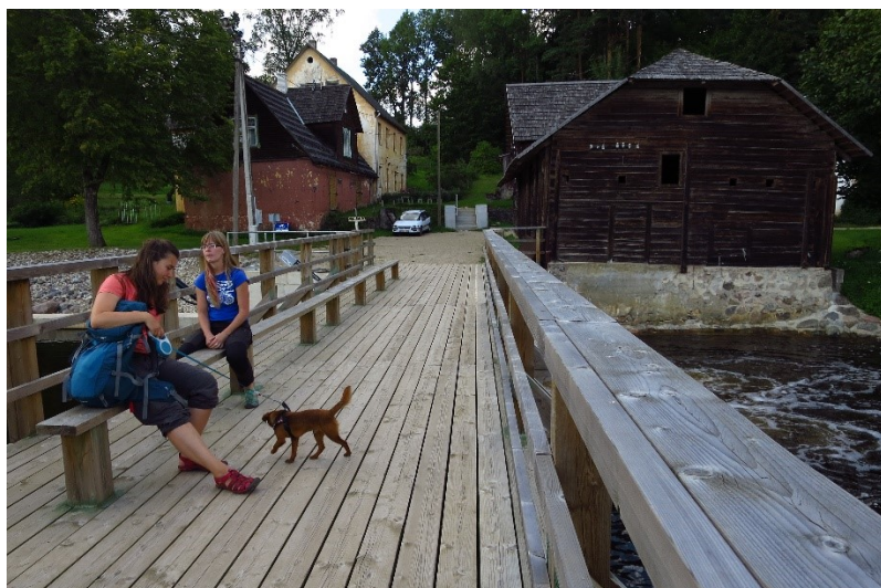
Joonis 5.12 Pinkidega jalakäijate sild Elva jõel Peedu vesiveski paisul.
